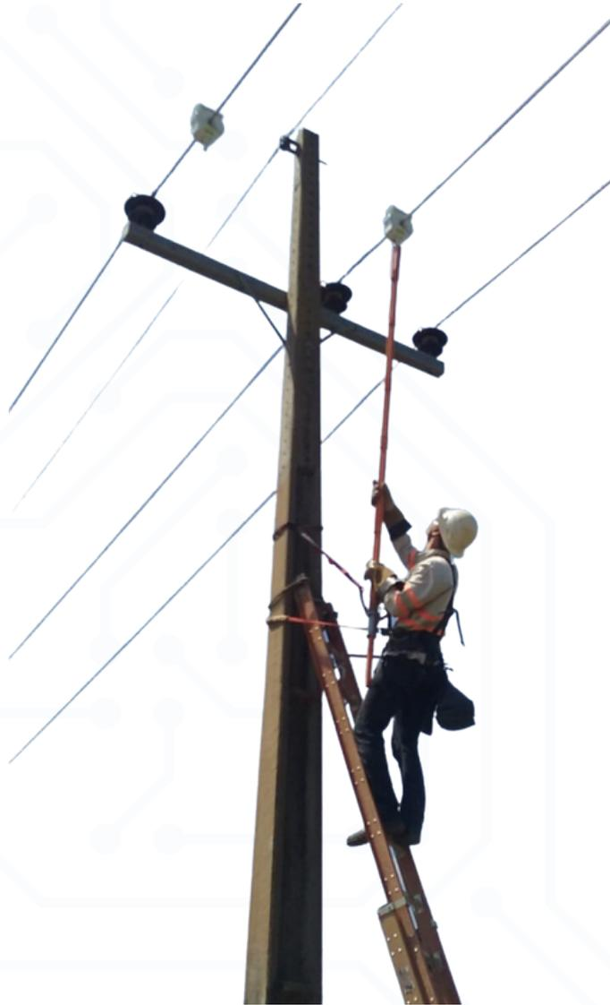
Figura 1: Instalación con escalera y pértiga de maniobra, sin necesidad de interrumpir el suministro eléctrico
