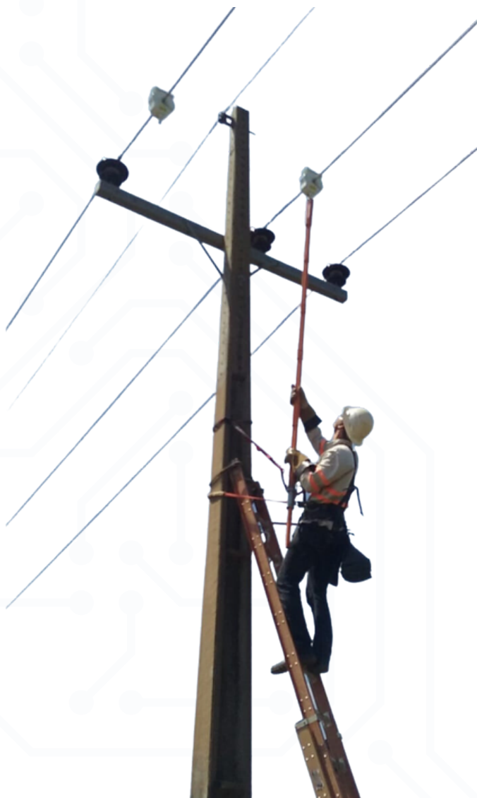
Figura 1: Instalação com escada e vara de manobra, sem a necessidade da interrupção no fornecimento da energia
